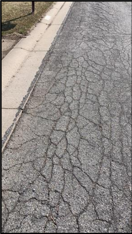
EDGE CRACKING
